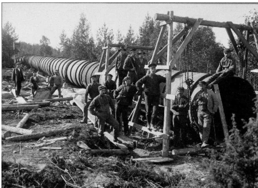
1911 byggdes denna ståltub vid träsliperiet Haga nära Hillringsberg i Värmland. Forsensfallhöjd var 20 m, men den var mycket långsträckt och med en tidigare "sump" kunde man inte utnyttja hela fallhöjden, vilket man nu kunde. Denna typ av tuber av stål eller trä byggdes allmänt vid träsliperierna runt förra sekelskiftet och kunde sedan användas när de flesta små träsliperier byggdes om till vattenkraftverk.
