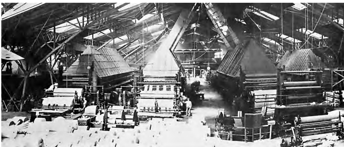
Kvarnsvedens pappersbruk med sex pappersmaskiner ca 1910. Dessa maskiner tillverkade då ca 35 000 ton papper per år och försörjdes av nio slipverk och en sulfitmassa-fabrik. Den stora maskinhallen hade tidigare varit utställningshall vid Stockholmutställningen 1897. Den var ritad av Ferdinand Broberg och tillverkad av stål från Domnarvets järnverk. Den köptes, demonterades och restes igen i Kvarnsveden (Stora Ensos bildarkiv i Dalarnas museum)
