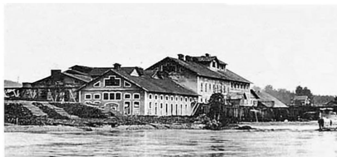
Stjernfors bruk, 1889-1918, beläget nära Uddeholm i Värmland. De tidiga försöken på 1890-talet med elektrolys för framställning av naturumhypoklorit fick överges då utrustningen, frättes sönder. 1916 byggdes en ny anläggning med kvicksilverelektroder. När Stjernfors lades ned flyttades denna anläggning till den nya fabriken i Skoghall.
