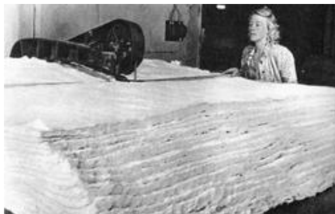
Cellulosaavadd tillverkades av krepptat papper som staplades i många lager och skars till ark, som på bilden.
