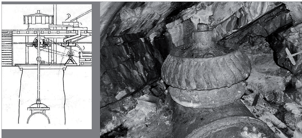
Turbinresterna från 1895, till höger på bilden, finns i en kulvert i Rottnerosfabrikens källare. Ritningen till vänster visar hur turbinen genom direktdrift drev den ovanför liggande slipstolen. (Ur "Papper och massa i Värmland")
