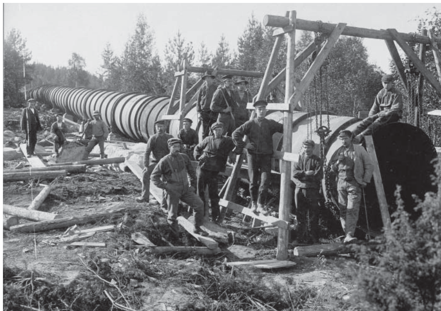
En stältub ersätter den tidigare sumpen 2 vid Haga träsliperi 1911. Tuben gav en fallhöjd av ca 20 m och kostade totalt 35 000 kr. Genom att leda vattnet i en 360 m lång sprängd kanal i bergssidan längs forsens i Glasälven, kunde man förkorta tubens längd från 600 m till 300 m. (Lennart Stolpe, privat)
