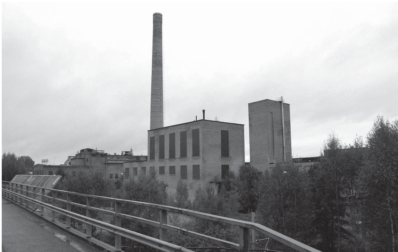
Anläggningarna i Deje före rivningen. Foto Lars Ohlsson
