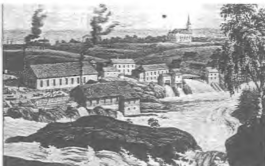
Att framställa massa genom slipning av trä mot roterande stenar var en epokgörande uppfinning på 1840-talet. Ett av världens första träsliperier anlades på Öman, en ö vid Trollhättan, år 1857.
