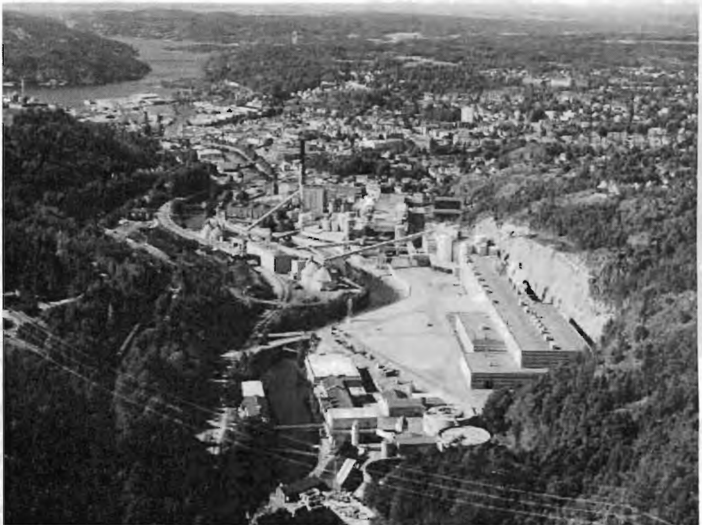
Saugbrugsanlegget på 1990-tallet: "Elven Tista slynger seg fremover på sin ferd mot havet. Saugbrugsforeningen ble tuftet på 1700- og 1800-tallet på grunnlag av fossekraften lenger opp i dalen og Tista som transportvei for tømmer og sagskur. I dag produserer bedriften bare SC magasinpapir. Det skjer i tre maskiner, PM 4, PM 5 og PM 6. Nederst midt i bildet ser vi de gamle bygningene etter Ankers kartongfabrikk. Til høyre ligger Norske Skogs store investering på 1990-tallet: Saugbrugsforeningens sjette papirmaskin: PM 6. Den produserer like mye papir som PM 4 og PM 5 til sammen.
