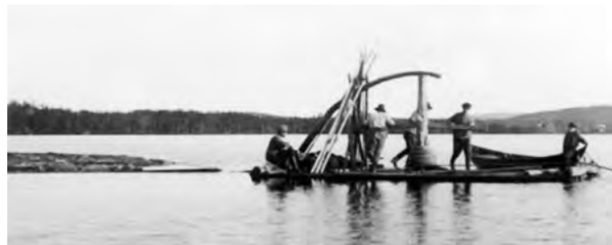
En spelflotte drar en lina från en "flot" av stockar till en fast förtöjningspunkt, varefter en manuell vinsch på flotten förhyttar floten över sjön. Proceduren upprepas tills man når utloppet ur sjön och strömflothing kan ta vid. Floten hölls ihop av en "läns" av sammanhängande stockar.
